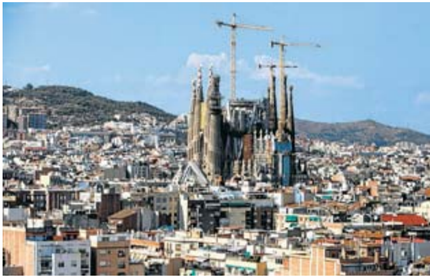
Les columnes de la façana de la Glòria ocupen part del carrer. C. ATSET
