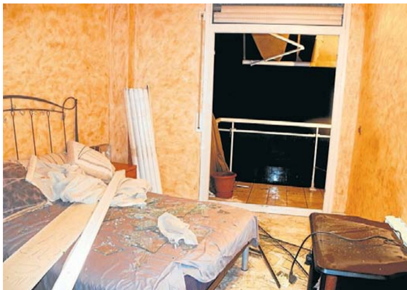
Destrosses en un habitatge de Valls arran de la tromba d'aigua i el fort vent d'ahir a la tarda. ROGER SEGURA / ACN
